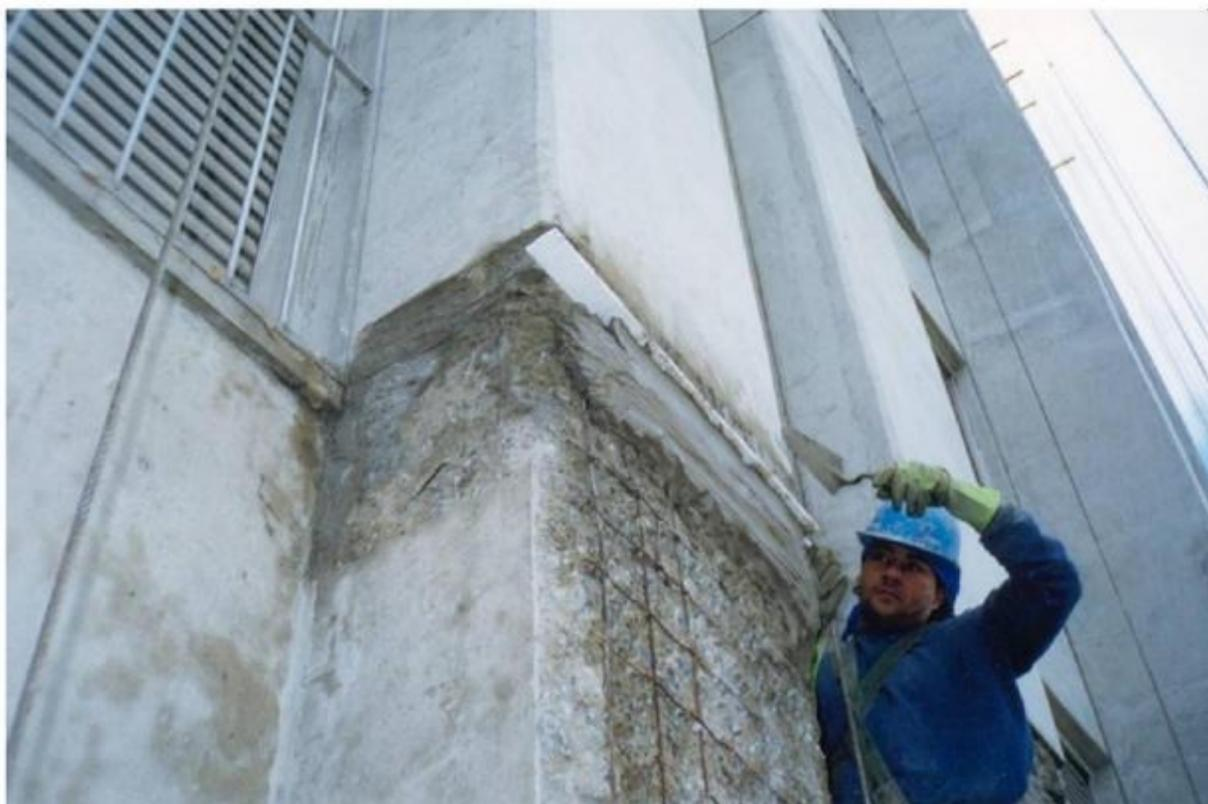
Fig. 3 – Recuperação de concreto armado com argamassa polimérica em MG. <sup>(6)</sup>
