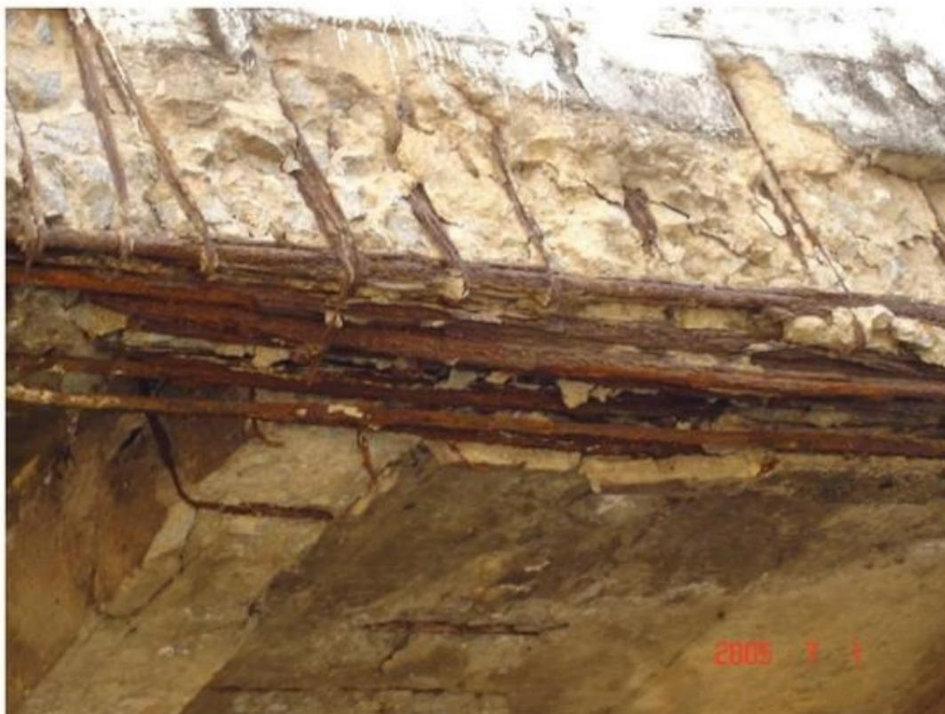
Fig. 1 – Corrosão generalizada em estrutura de Adutora em Betim – MG. <sup>(6)</sup>
