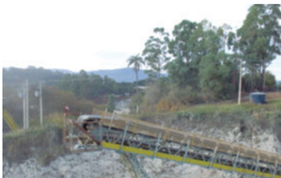
Figura 2 - Vista da estrutura do Transportador - detalhe avaliado. Fonte: autor.
