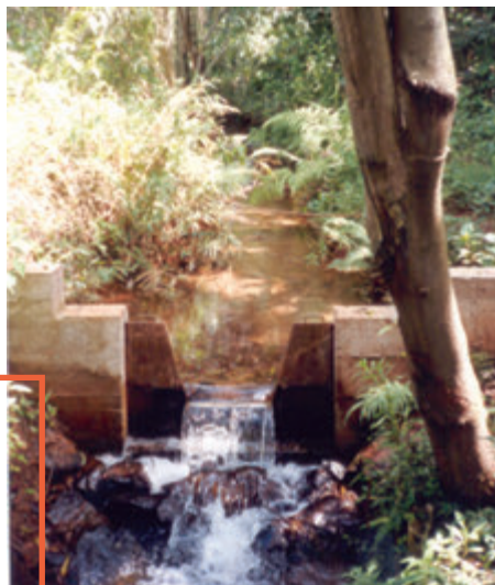
Figura 1 Vertedouro com régua na parte posterior da estrutura
