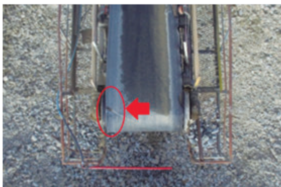
Figura 4 - Princípio de ruptura na emenda. Fonte: autor.
