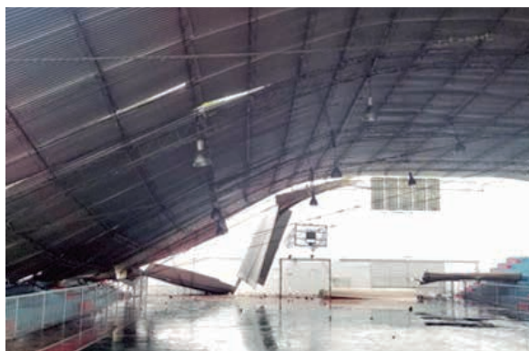
Figura 1 - À esquerda, vista externa do telhado após o sinistro e, à direita, vista interna. Em ambos os casos, nota-se que o sinistro ocorreu em lado específico, o que sugere fortemente fratura localizada em algum ponto do lado que ruíu.
