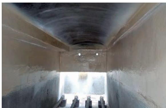
Figura 2 - Estrutura interna recuperada e protegida. Fonte - pp. autor (2019).
