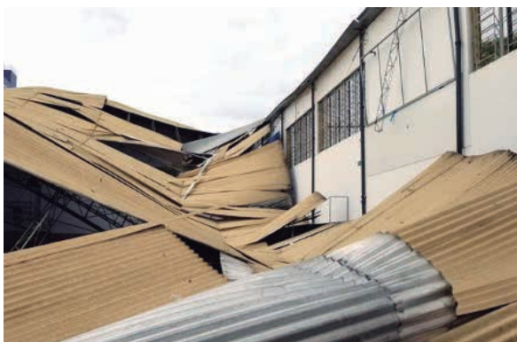
Figura 1 - À esquerda, vista externa do telhado após o sinistro e, à direita, vista interna. Em ambos os casos, nota-se que o sinistro ocorreu em lado específico, o que sugere fortemente fratura localizada em algum ponto do lado que ruíu.
