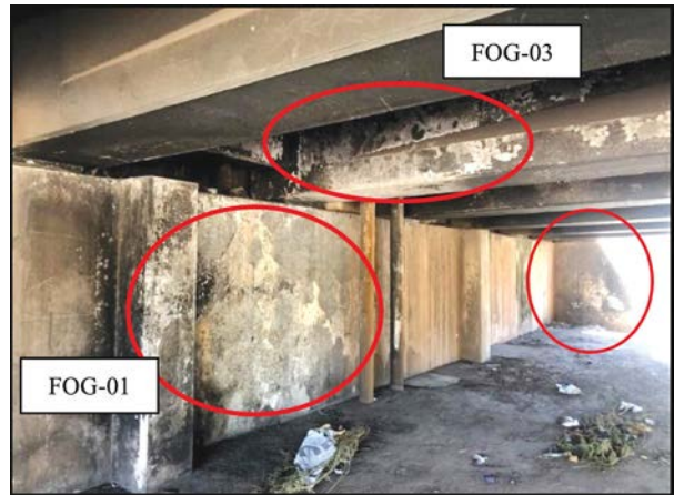
Figura 2 - Ação do fogo
