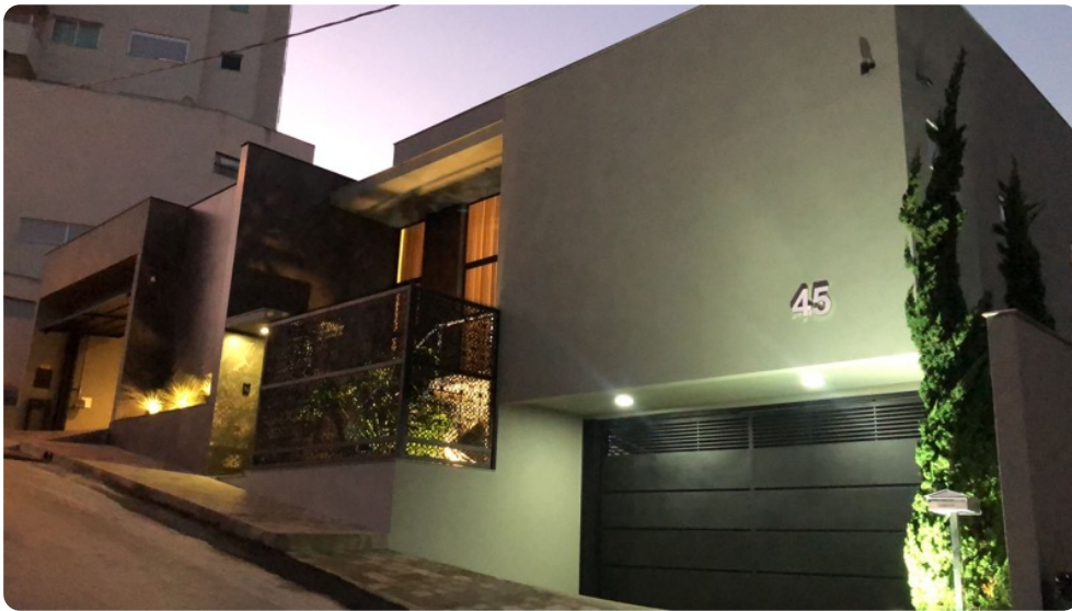
Imagem 13 - Foto da casa recuperada
