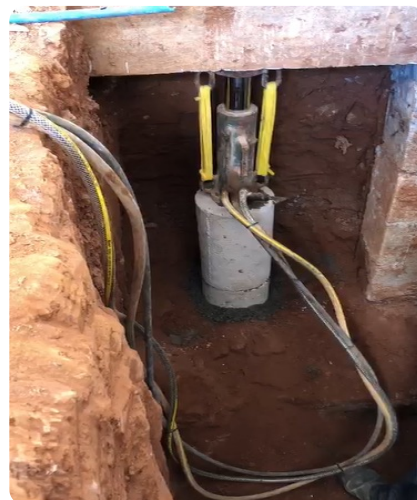
Imagem 8 - Execução das estacas prensadas, através de equipamento hidráulico com manômetro
