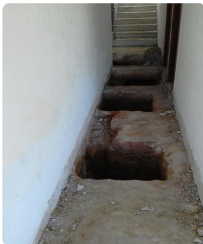
Imagem 7 - Preparo para cravação das estacas no nível do subsolo, iniciado em 02/08/2022
