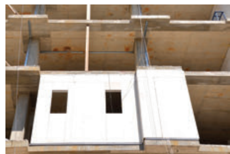
Figura 01 - Sistema de Vedação Externa em Painéis leves, com função estrutural • Fonte: Sistema Intelitec - Vantem global, 2016
