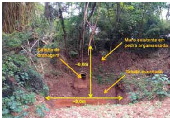
Imagem 1 - Características do talude
