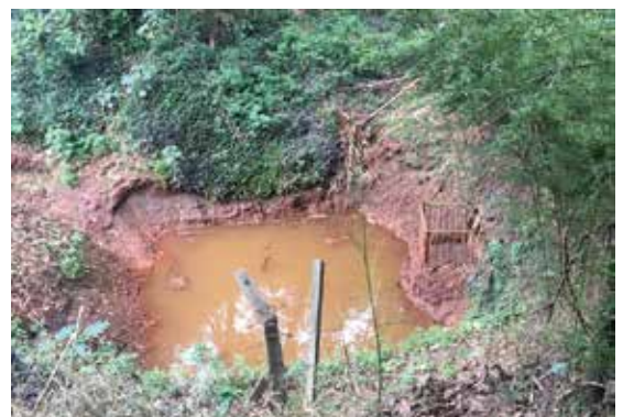
Imagem 2 - Vista superior da bacia escavada.
